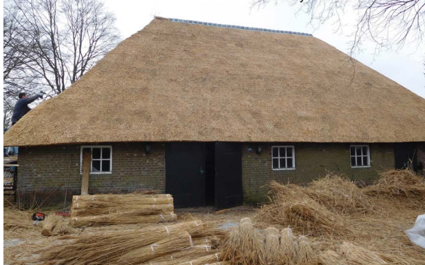
Restauratie Vlaamse Schuur Eendenboerderij Helvoirt
